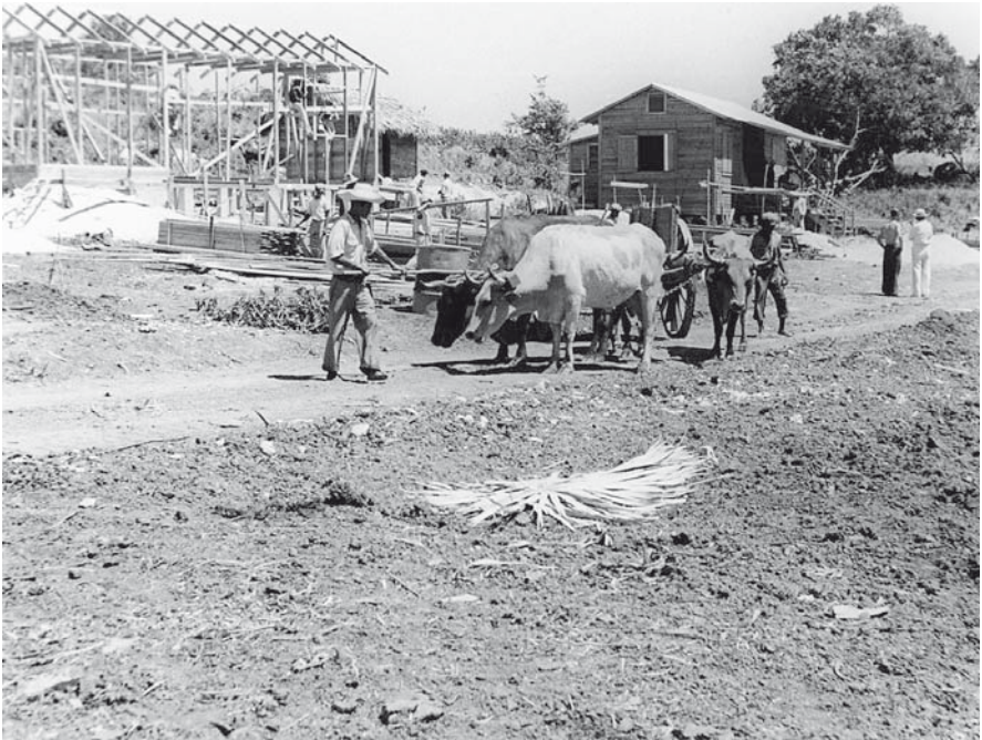
Bau der Siedlerhäuser
