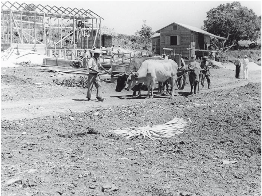
Bau der Siedlerhäuser
