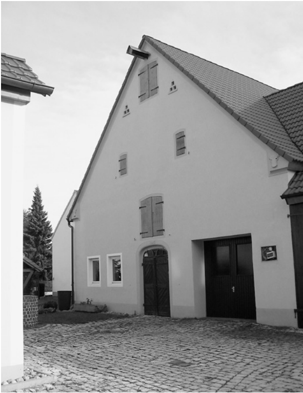
Abb. 2: Stall der ehemaligen Viehhandels-Firma »Simon Behr & Söhne«, das Stallgebäude wurde im Jahr 1923 neben dem Wohnhaus in Mönchsroth errichtet.
