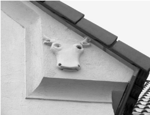
Abb. 3: Detailansicht der Scheune der Viehhandlung »Simon Behr & Söhne«, Mönchsroth, linke Hauswand.
